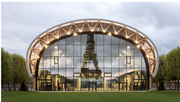
La façade du Grand Palais Éphémère ©Patrick Tourneboeuf pour la Rmn - GP, 2021 architecte Jean-Michel Wilmotte
